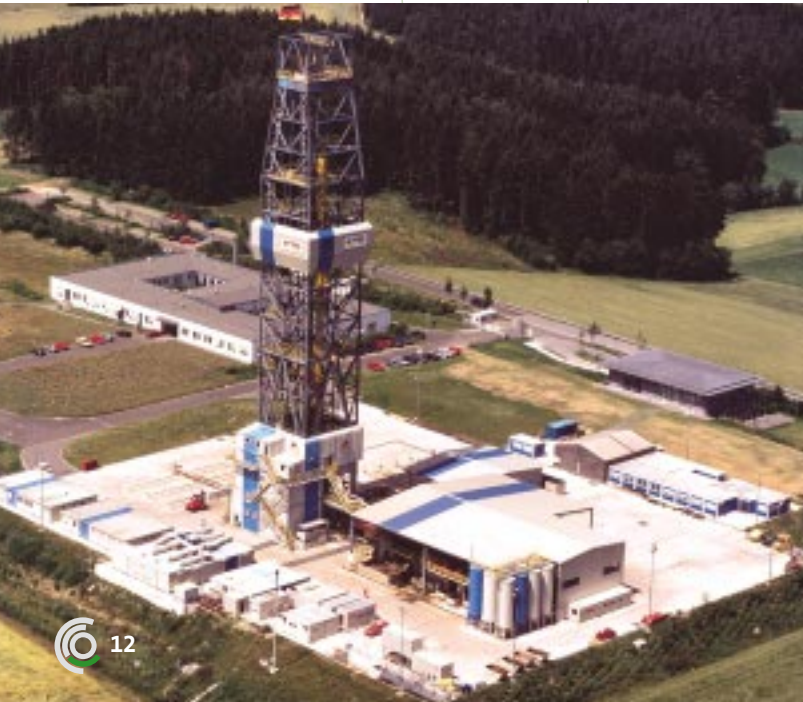
Der 83 Meter hohe Bohrturm des Kontinentalen Tiefbohrprogramms in der Oberpfalz. Damit haben sich Wissenschaftler mehr als neun Kilometer tief in die Erdkruste gebohrt.
